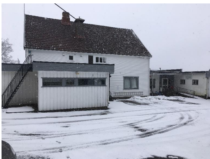
Hovedbygget er påbygd i flere etapper
