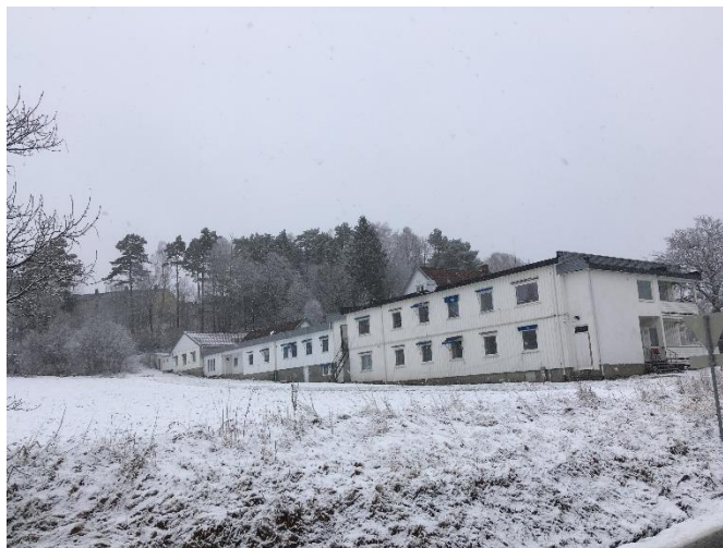
Hovedbygget sett fra sørvest
