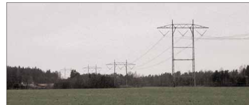
Store overføringslinjer med el-kraft båndlegger store arealer som ikke kan bebygges, reduserer skogproduksjonen (åpne gater) og er dominerende i landskapsbildet.
