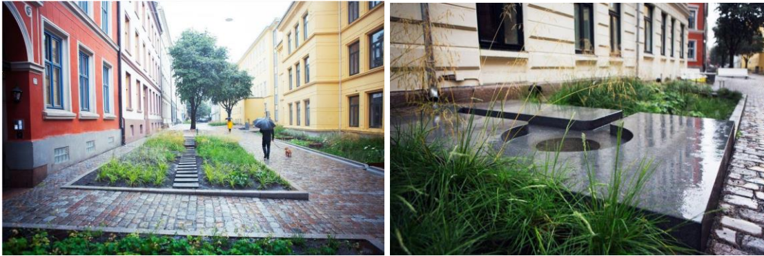
Bilde 24 og 25 Eksempler på lokal overvannshåndtering i gatetun, Deicmans gate Oslo (Kilde: Asplan Viak, foto Åse Holte)
