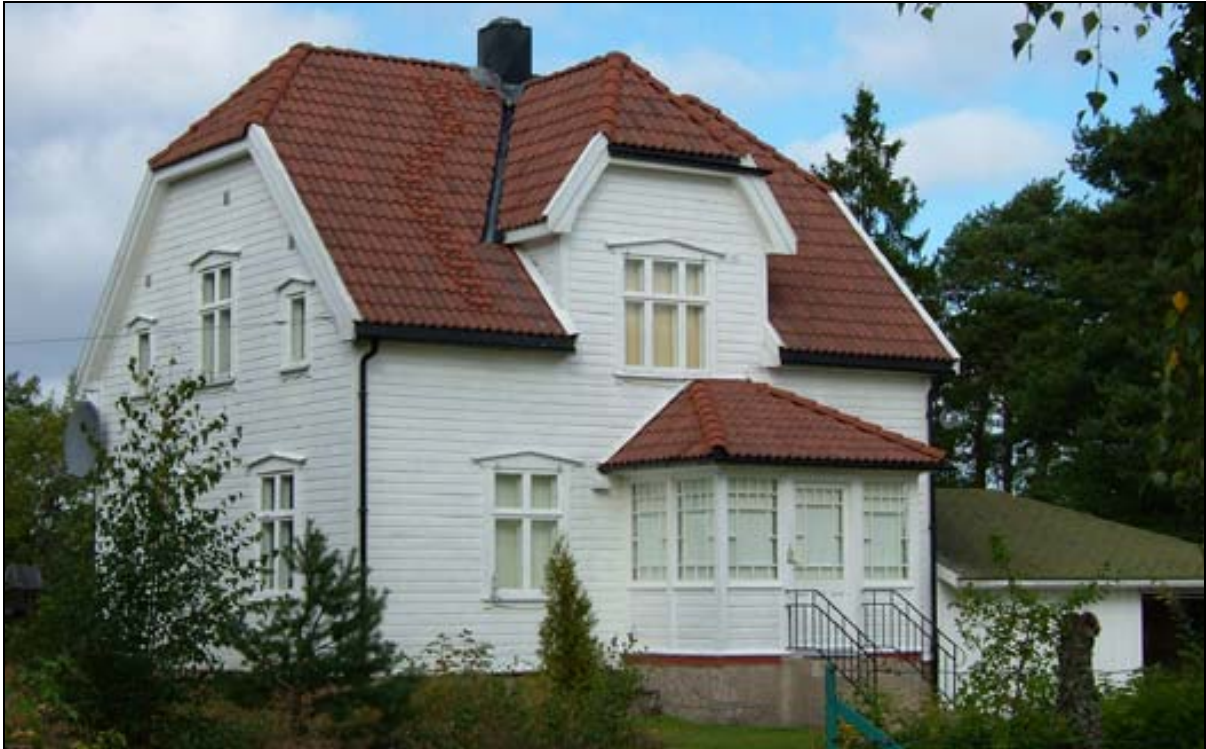
Figur 6. Typisk hvalfangerbolig fra perioden 1900-1940. Boligene er av høy arkitektonisk og håndverksmessig kvalitet og forteller om velstand og gode levevilkår for dem som var knyttet til denne næringen. (Bilde fra Hindhamar AS, Landskapsarkitekter MNLA 2005: Stedsanalyse Saltnesområdet, Råde kommune)
