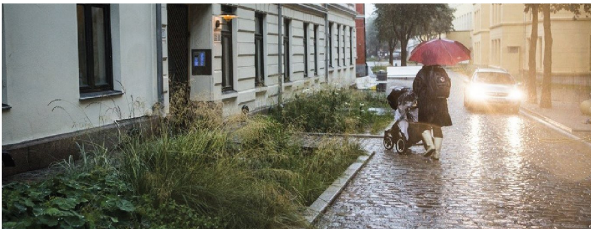
Deichmans gate i Oslo med regnbed for lokal overvannshåndtering
