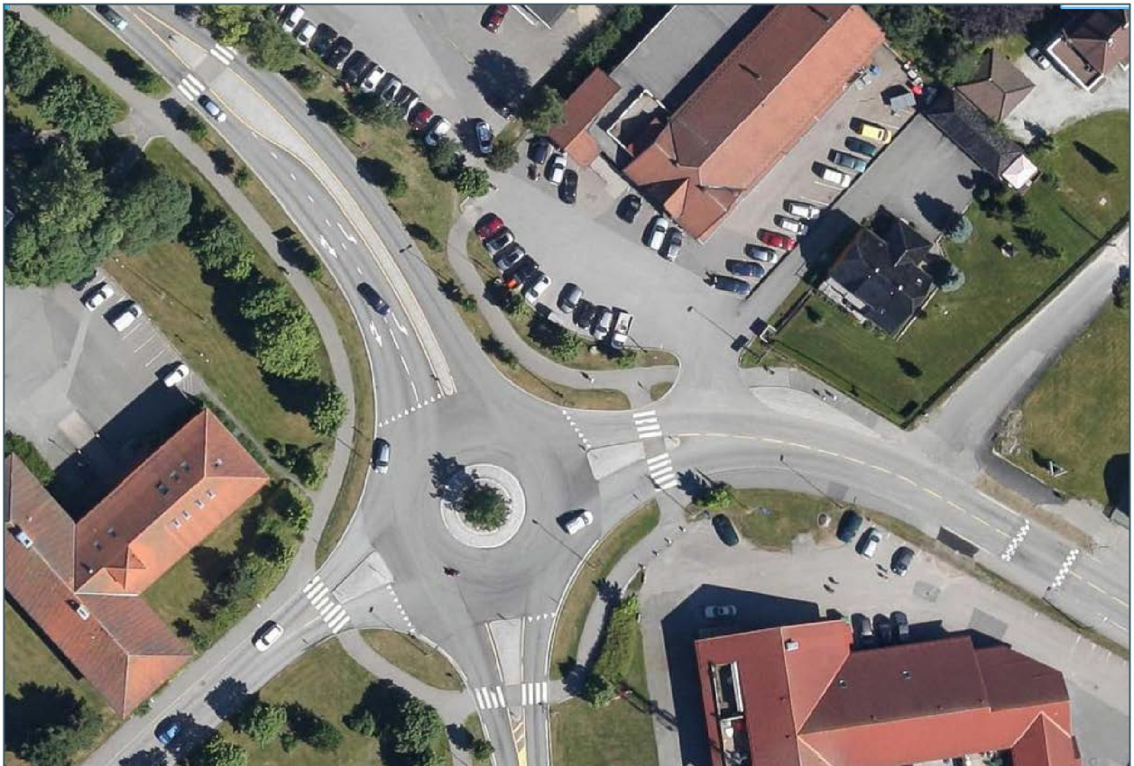
Figur 16 Flyfoto over rundkjøringen Rv 110 X Fv 108 i dagens situasjon (kilde: www.finn.no )
