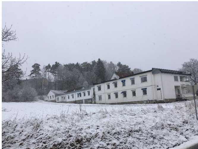
Hovedbygget sett fra sørvest
