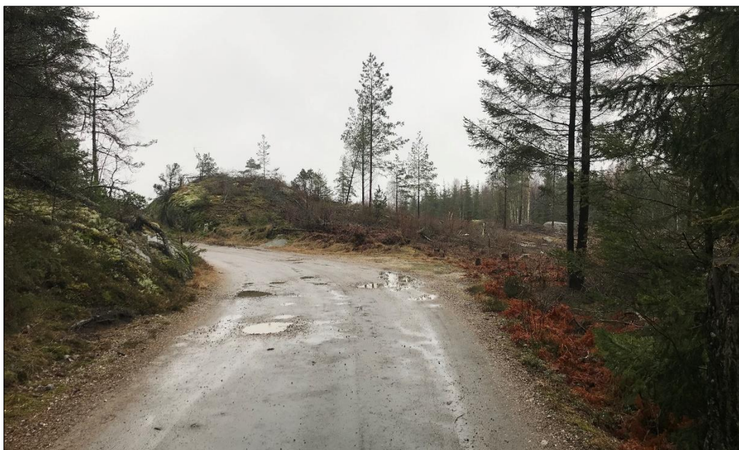
Figur 19 Veien Torkildstad nordøst i planområdet, sett mot sør. Kollen er innenfor GBG5.
