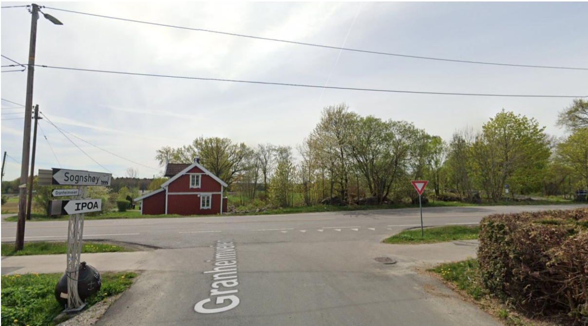
Figur 2-12: Det er god sikt og det er belysning i dagens avkjørsel fra Mosseveien. Gang-/sykkelvegen er trukket ca. 3 m tilbake i kryssområdet, og ikke 5 m iht. krav i N100. Foto: Google StreetView, mai 2024.
