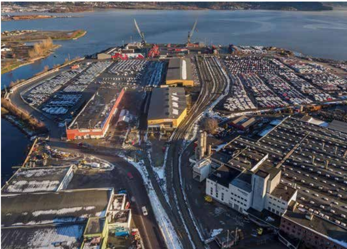
Figur 2.12 Den nye terminalen med jernbaneforbindelse på Holmen i Drammen (foto: Nils J. Maudal).
