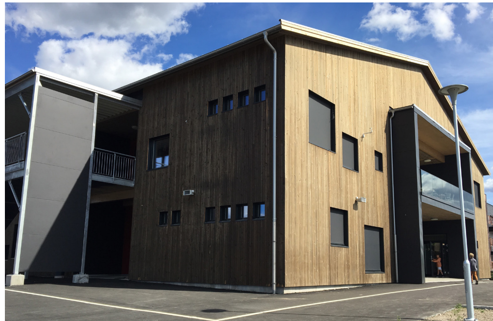
Tilbygg Karlshus skole i massivtre og passivhus-standard.
