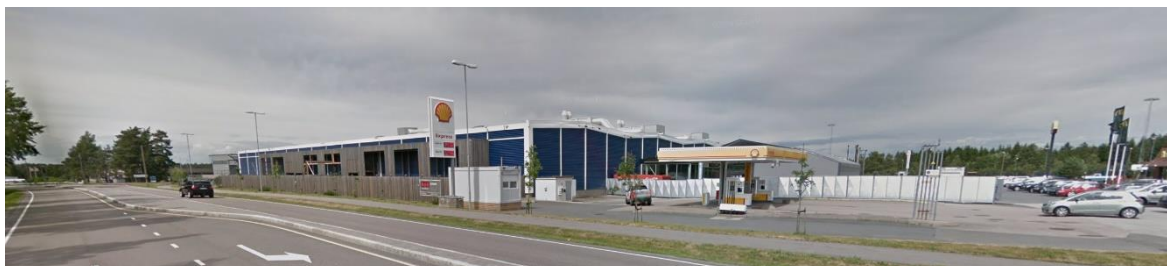
Eksisterende anlegg fra sydvest
