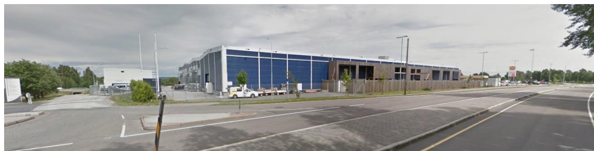
Eksisterende anlegg fra nordvest
