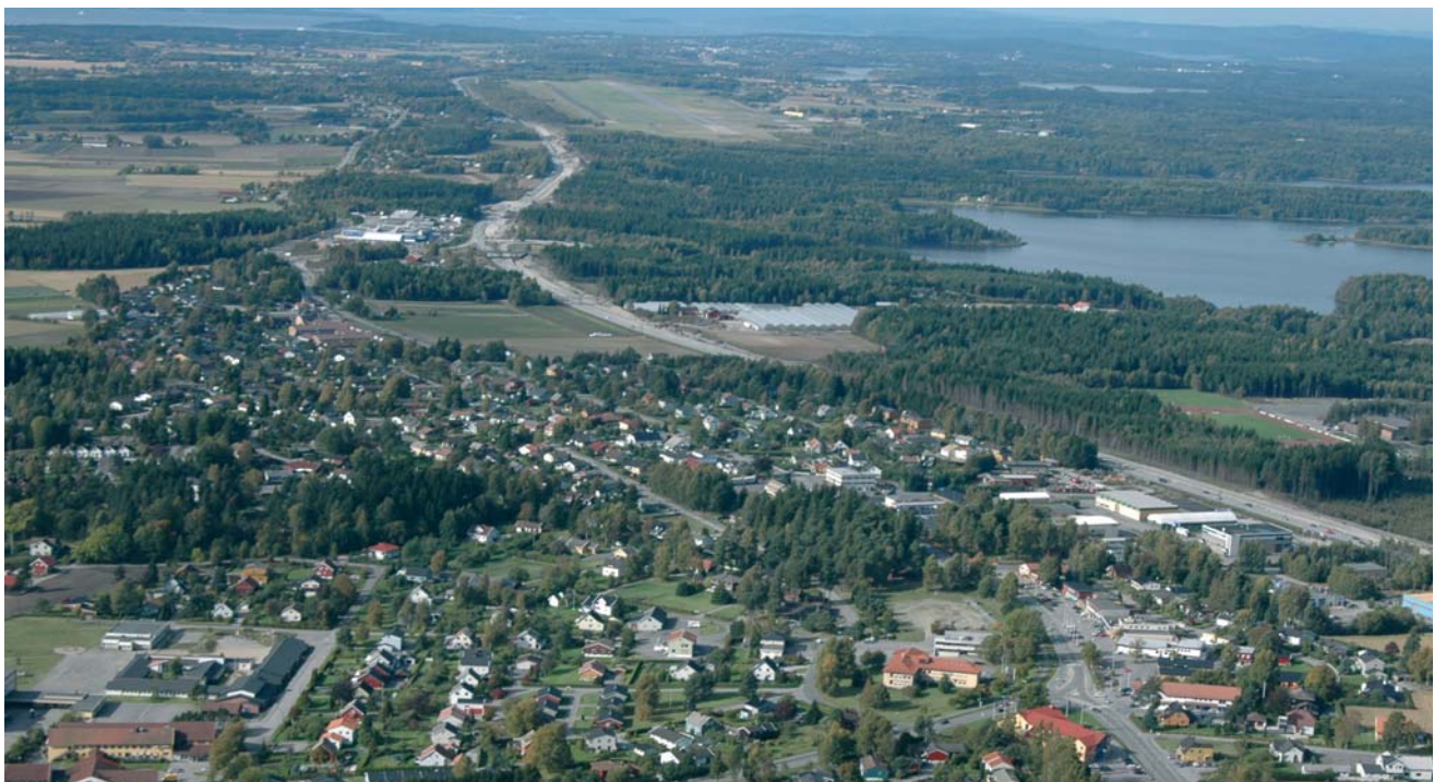
Karlshus med infrastruktur (Foto: 2004)
