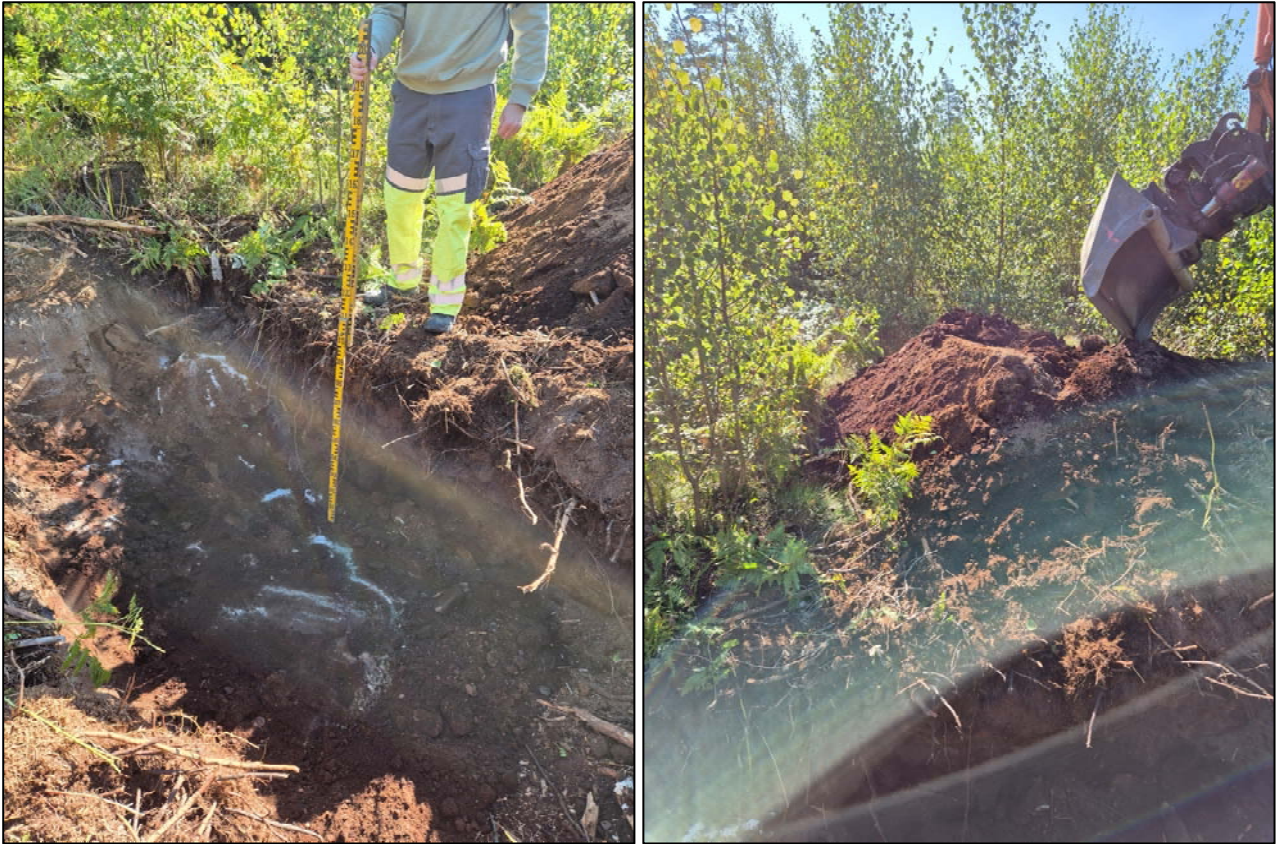
Figur 3-2: Bilder fra prøvegrop 1. Fjell ca. 1 m under terreng.
