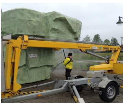
Buldrestenen på Tusenårsplassen ble rehabilitert våren 2016. Den ble vasket og påført ny maling.
