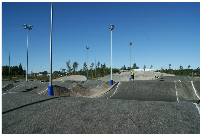
RÅDE BMX Arena – ferdigstilt sommeren 2016.
