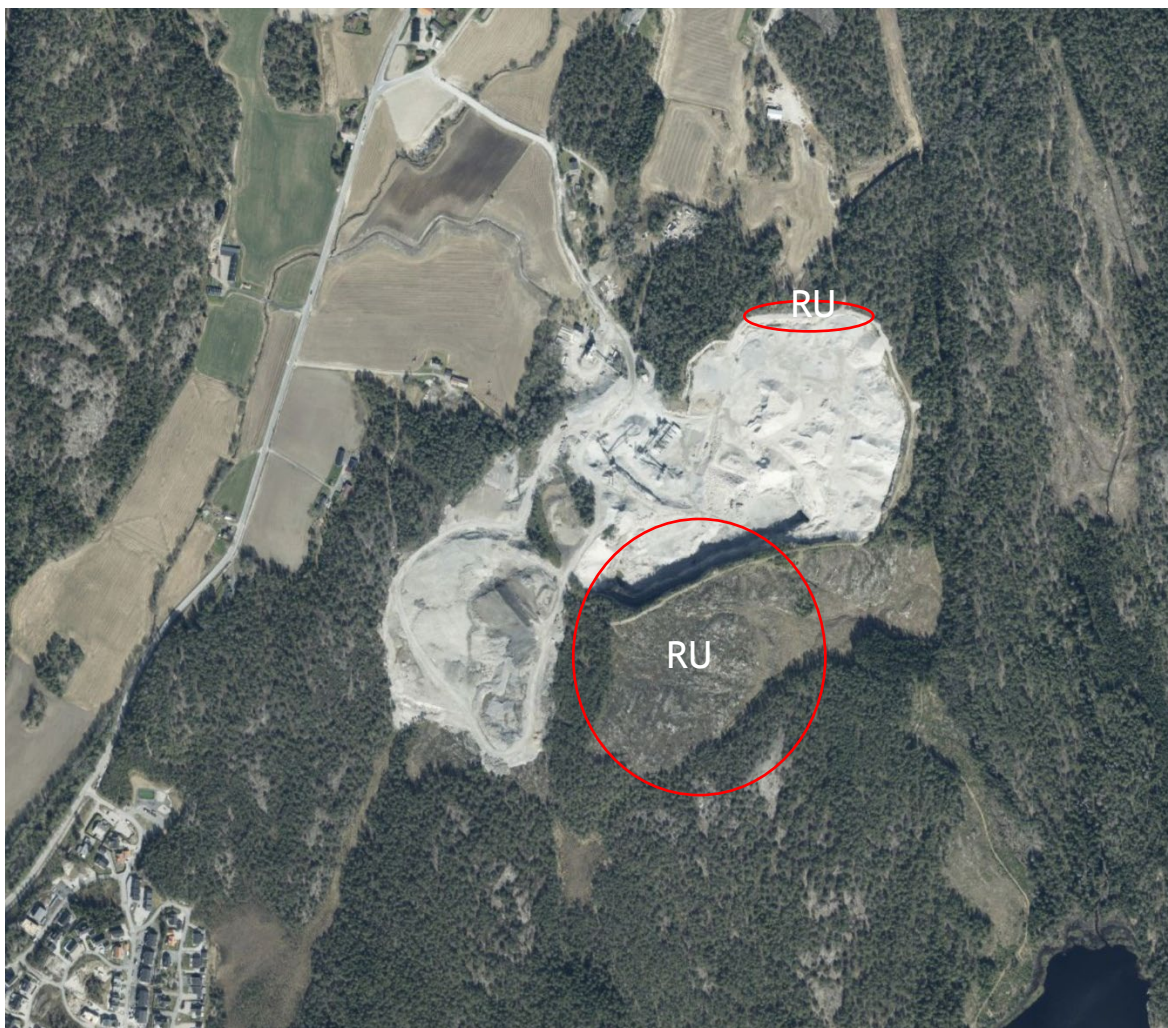
Figur 2: Ortofotoet viser dagens situasjon og arealbruk. Områdene som inngår i detaljreguleringen av Råde pukkverk, ligger nord og sør for dagens pukkverk. Området i sør omfatter et avskoget område og områder med furuskog. Utvidelsesområdet i nord ligger innenfor dagens regulerte skjermingsbelte. Utvidelsesområdene for pukkverket er angitt med rød sirkel og teksten RU. Utsnitt fra norgeskart.no.
