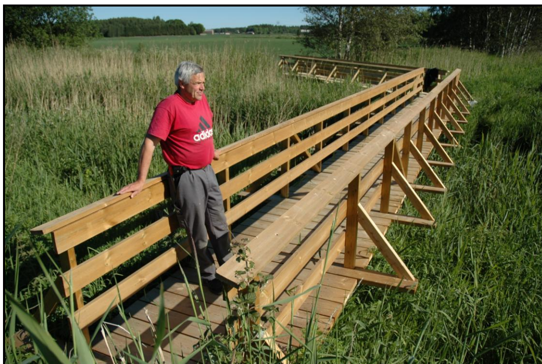
Gangbro over Heiabekken og Rosnesbekken (2007)
