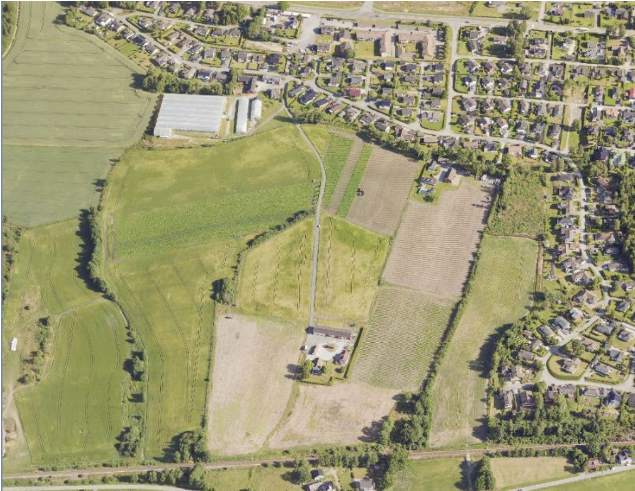
Figur 7-7-1 Flyfoto av Skråtorpområdet tatt i 2017
