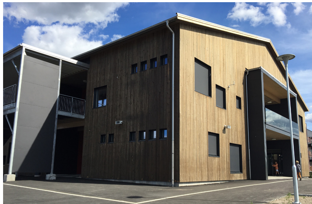
Tilbygg Karlshus skole i massivtre og passivhus-standard.
